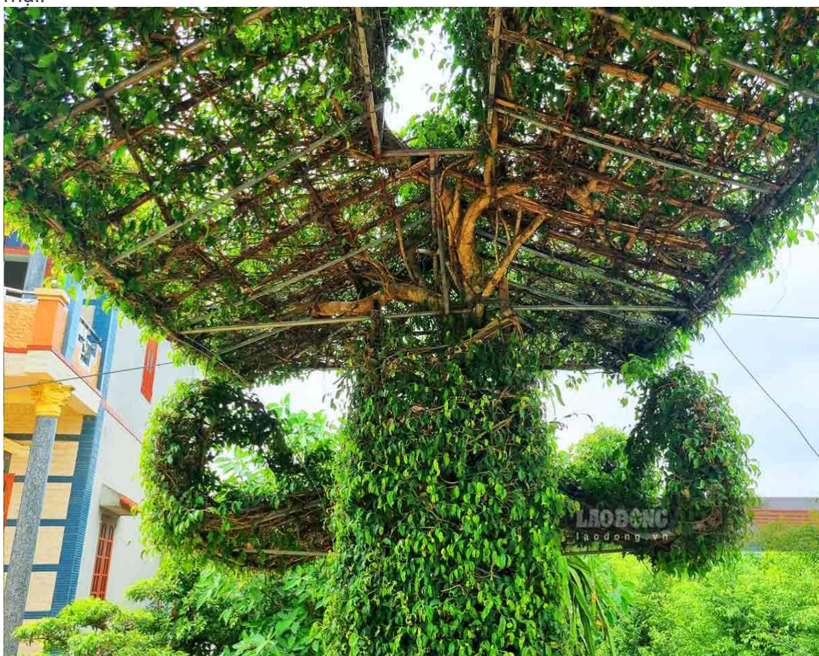
Phần khung và giàn đỡ mái của cổng được làm bằng khung sắt chắc chắn.
