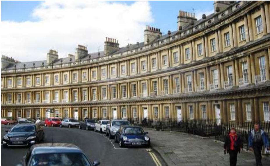
Nhà ở thành phố Bath
