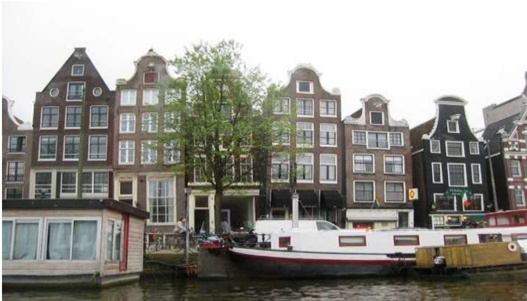
Nhà phố và nhà bè hai bên kinh đào
