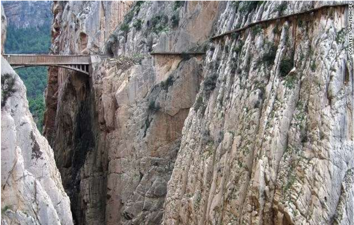
El Caminito Del Rey là cây cầu rộng 1 m bắc qua hẻm núi ở Malaga, Tây Ban Nha. Mặt cầu nằm cách mặt sông phía dưới 100 m.
