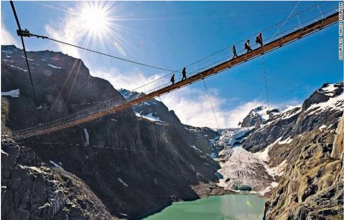
Cầu Tift bắc qua con sông băng cùng tên ở Gadmen, Thụy Sĩ. Biến đổi khí hậu khiến dòng sông băng Tift thu hẹp, buộc người ta phải xây dựng cây cầu treo dài 170 m để phục vụ đi lại.
