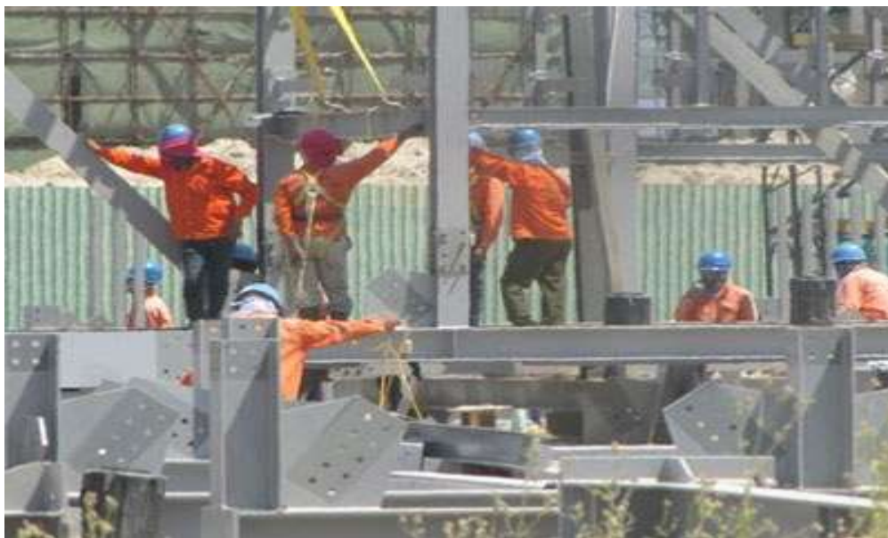
Một công trình xây dựng tại KCN Vũng Áng do nhà thầu Trung Quốc thi công. Courtesy photo.
