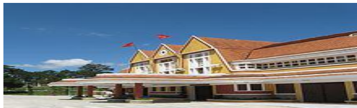
Nhà ga xe lửa Đà Lạt , xây dựng từ năm 1932 đến năm 1938, ngày nay trở thành một địa điểm du lịch.
