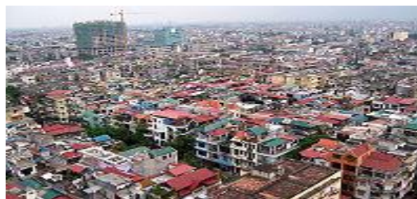
Hà Nội đang xây dựng, 2004
